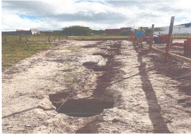
FOTO 15: Escavação fundação (Muro)
