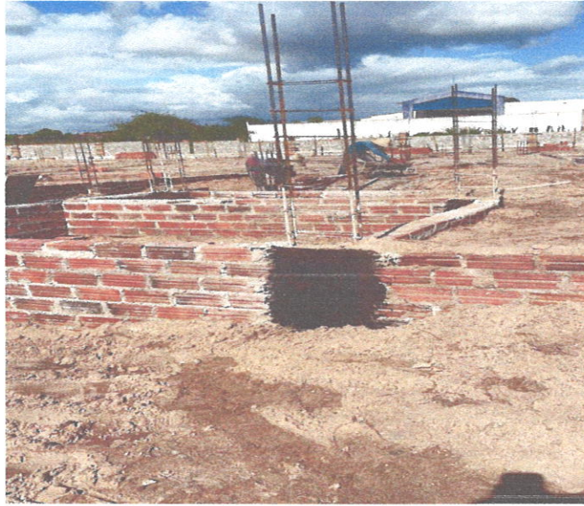
FOTO 25: Levante alvenaria de embasamento e impermeabilização pilar
