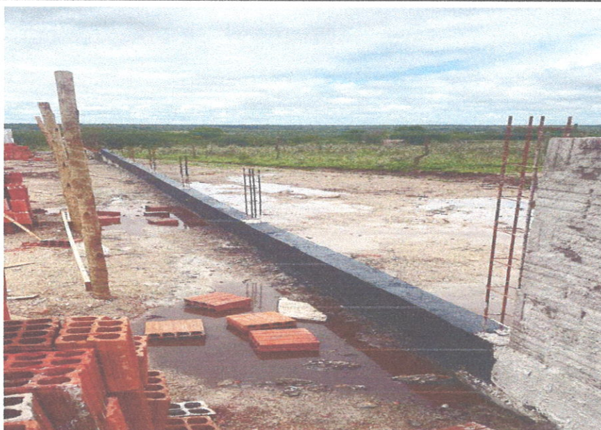
FOTO 20: Impermeabilização de viga baldrame (muro)
