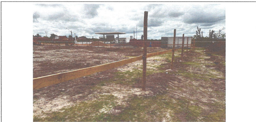
FOTO 2: Confecção de gabarito e locação de obra
