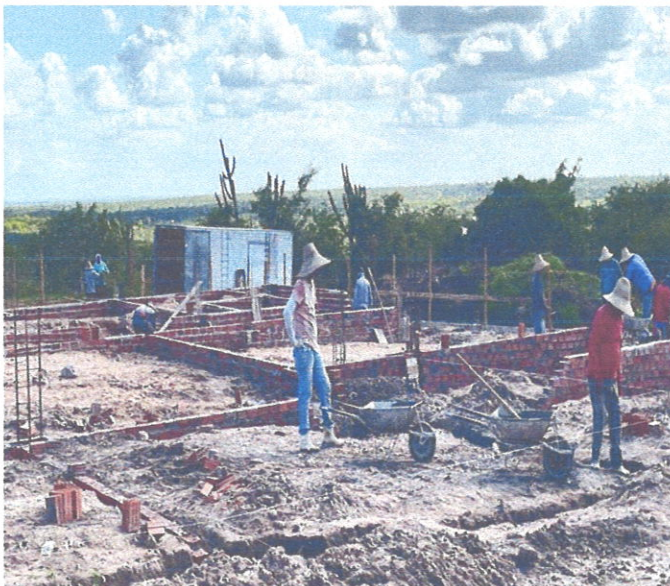
FOTO 27: Levante de alvenaria de embasamento
