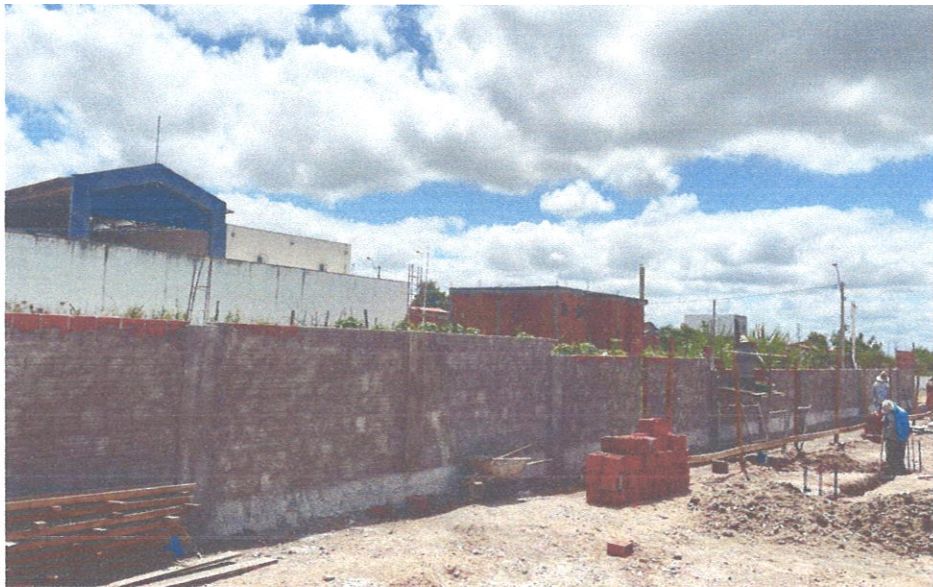
FOTO 22: Levante de alvenaria e chapisco
