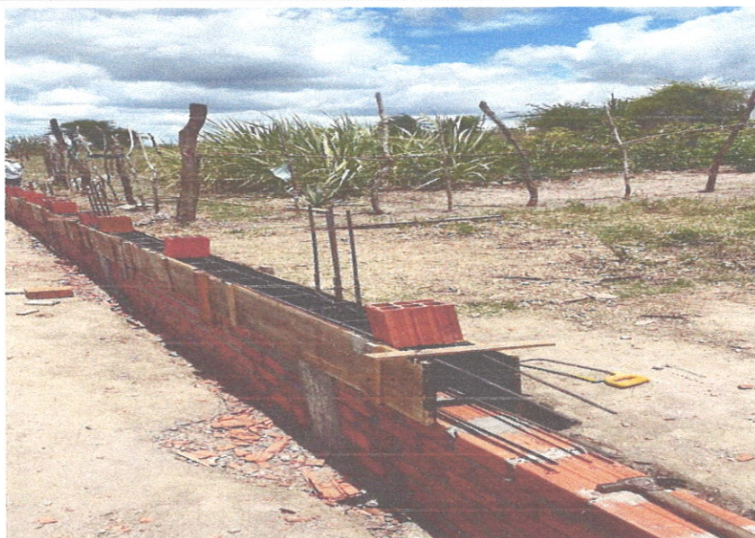
FOTO 17: Execução de forma - Viga baldrame (Muro)
