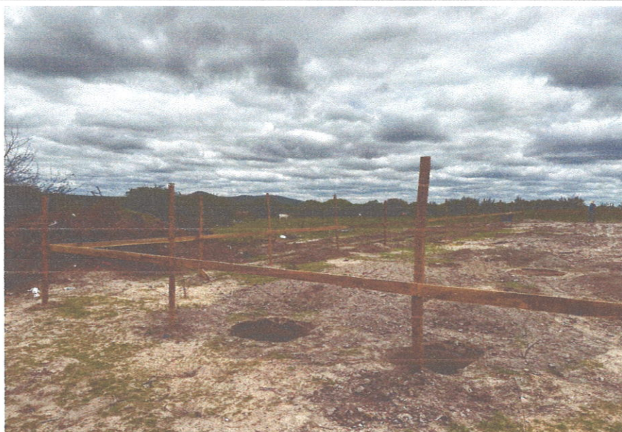
FOTO 4: Confeção de gabarito e locação de obra
