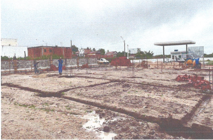
FOTO 23: Escavação valas – Viga baldrame
