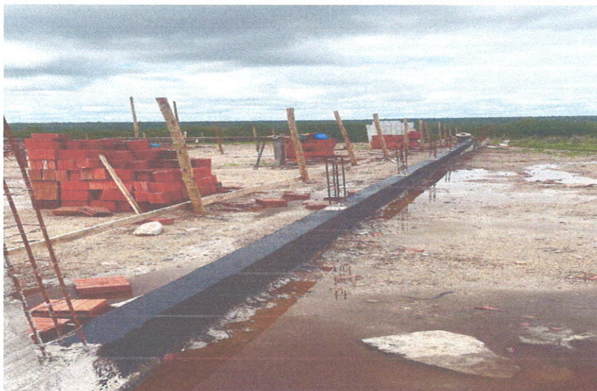
FOTO 19: Impermeabilização de viga baldrame (muro)
