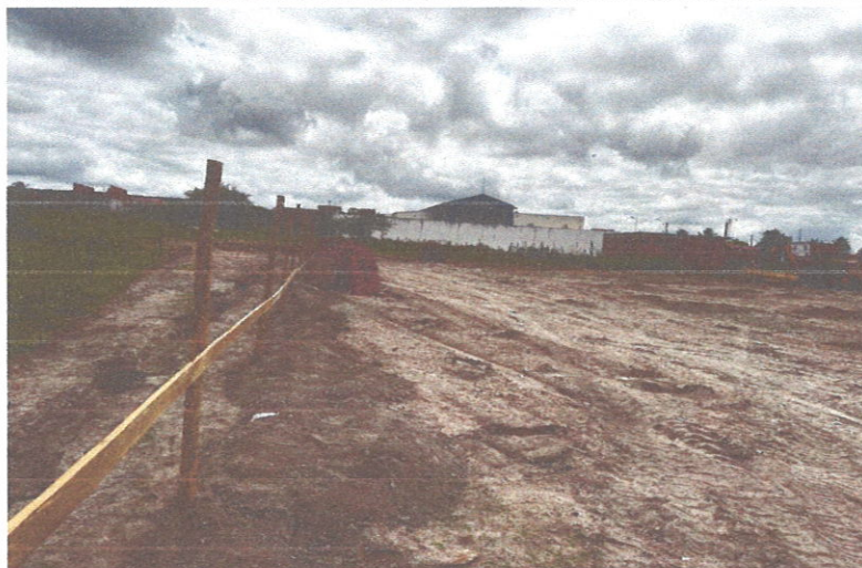
FOTO 3: Confeção de gabarito e locação de obra
