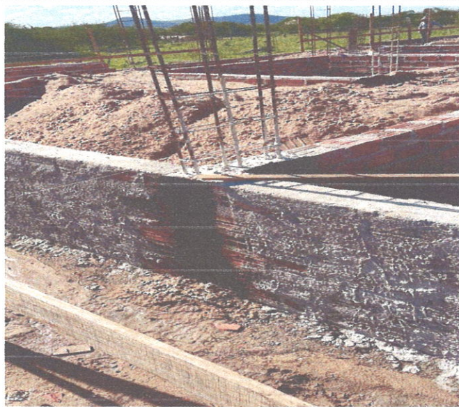
FOTO 26: Chapisco alvenaria de embasamento e impermeabilização
