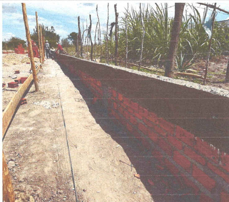
FOTO 18: Concretagem viga baldrame (Muro)
