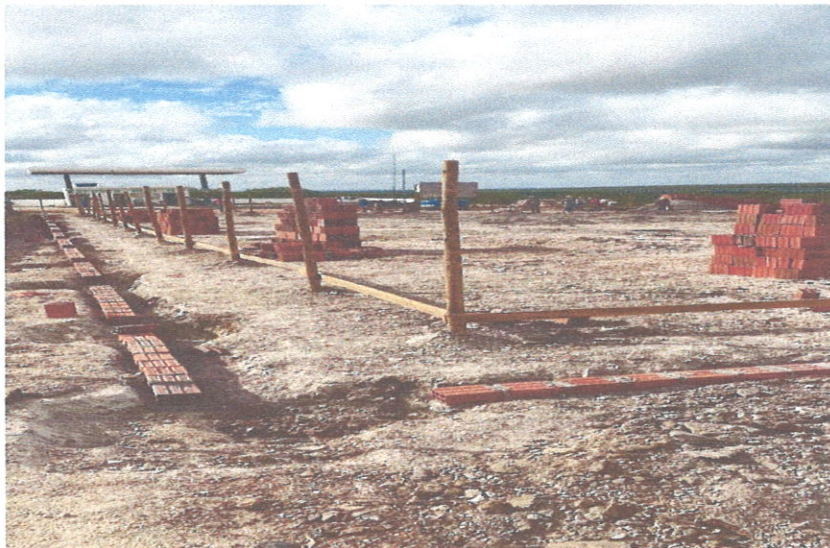
FOTO 16: Alvenaria de embasamento (Muro)
