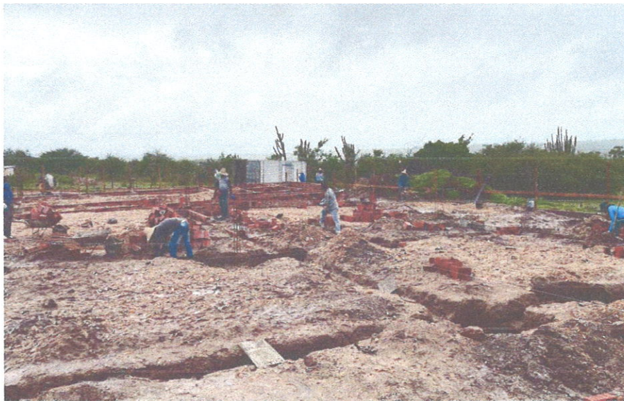
FOTO 24: Escavação valas – Viga baldrame
