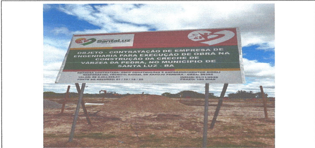
FOTO 1: Instalação de placa de obra em aço galvanizado
