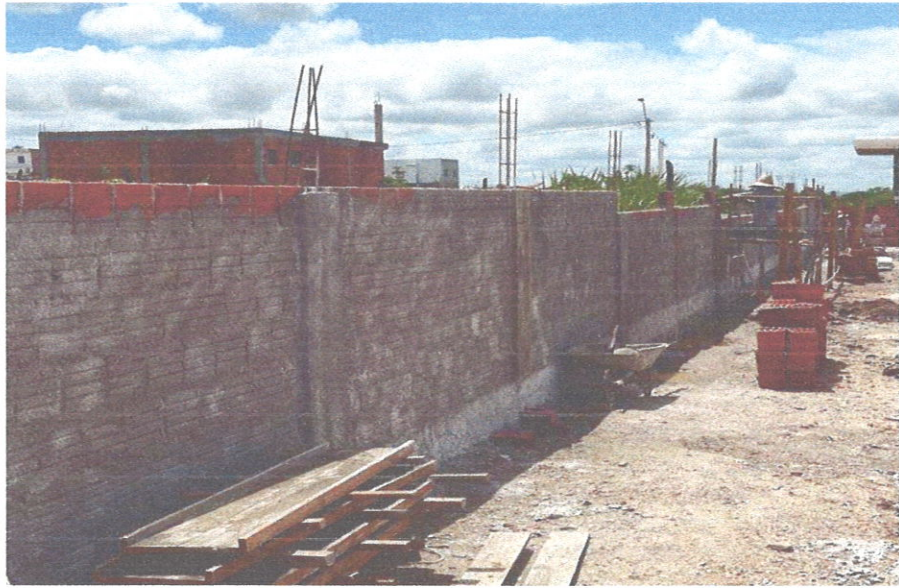
FOTO 21: Levante de alvenaria e chapisco
