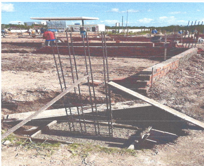
FOTO 28: Concretagem sapata
